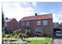
eenvoudig bouwvolume, schoorstenen
