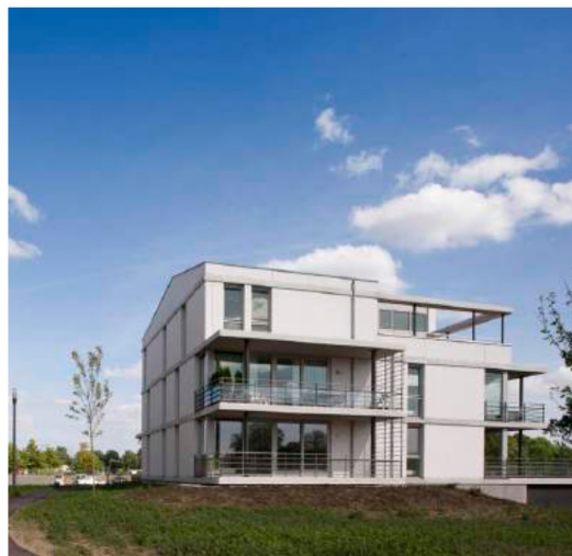
Appartementen centrum Nuenen
