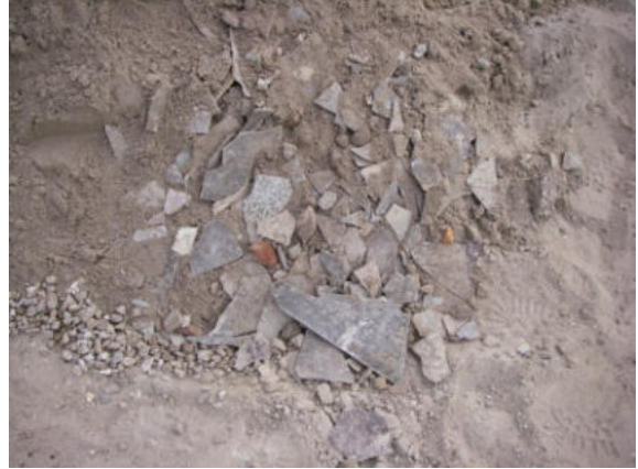
Asbestverdacht materiaal ASB01
