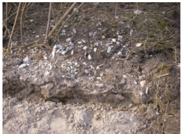
Asbestverdacht materiaal ASB12
