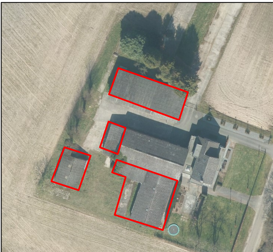
Afbeelding 2: Te slopen gebouwen (rood omlijnd)
